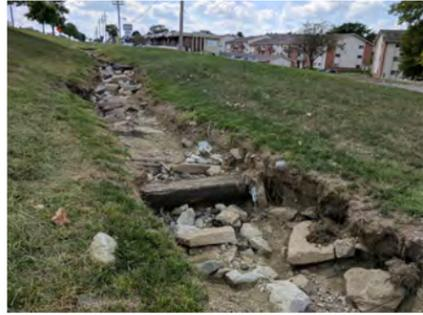
OPEN DRAINAGE CHANNEL WITH SEVERE EROSION
