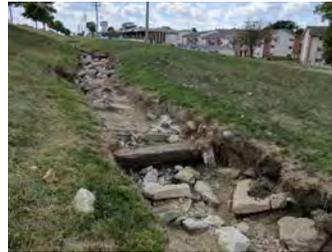
OPEN DRAINAGE CHANNEL WITH SEVERE EROSION
