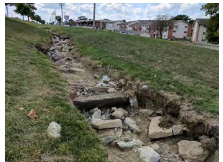
OPEN DRAINAGE CHANNEL WITH SEVERE EROSION
