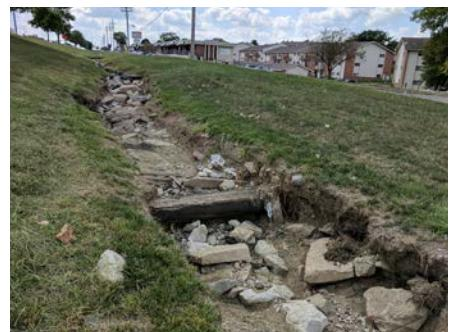
OPEN DRAINAGE CHANNEL WITH SEVERE EROSION
